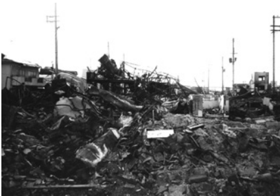
写真2-1 須磨区の被災状況
