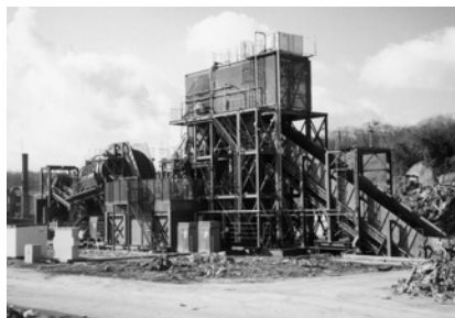
写真2-7 仮設破碎選別施設
