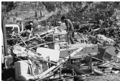
写真1-2 神戸市埋立地における災害廃棄物の搬入状況
